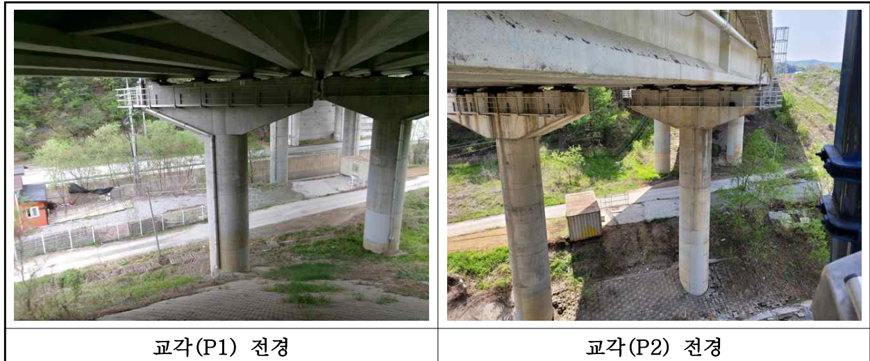
【사진 1.3.10】 교각 전경
