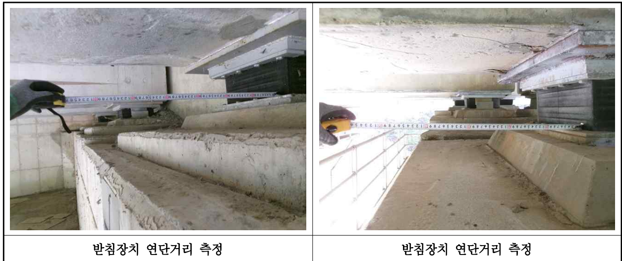
【사진 1.3.14】 교량받침장치 연단거리측정
