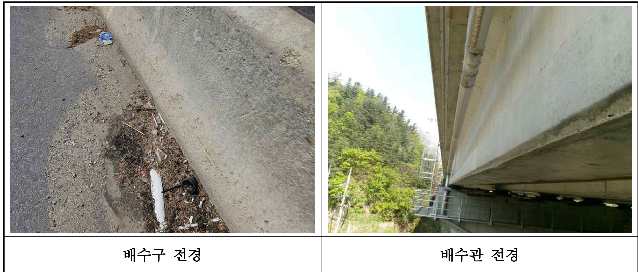
【사진 1.3.21】 배수시설 전경
