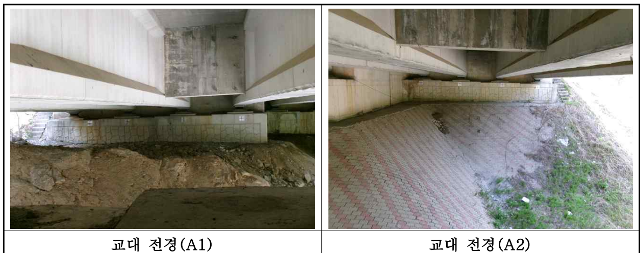
【사진 1.3.8】 교대 전경
