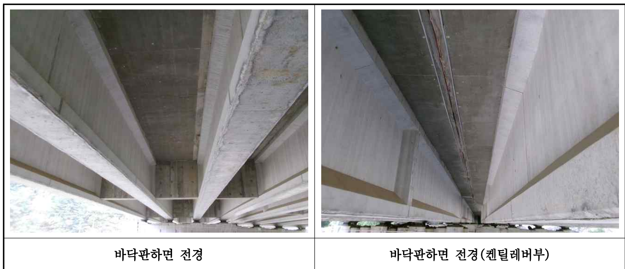
【사진 1.3.2】 바닥판하면 전경
